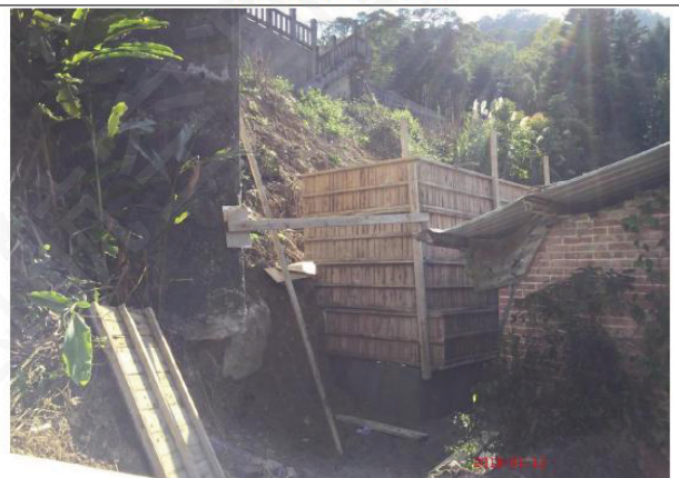
地面巡查計畫-現場照片
