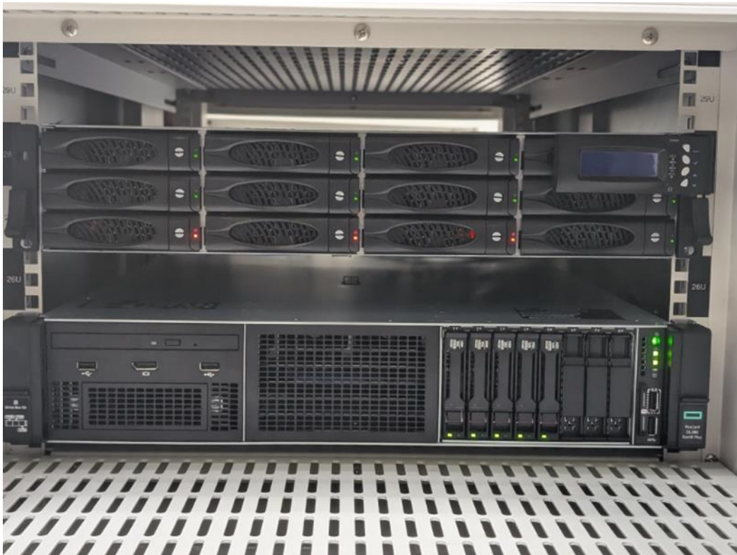
圖 2-34、於 GSN IDC 東七機房完成新主機上架
